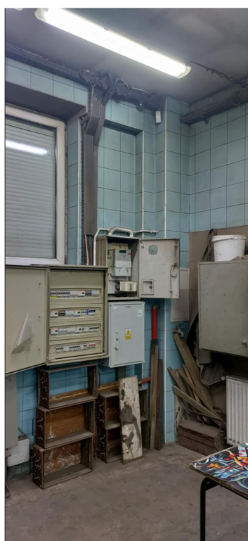
Ośrodek Pracy Twórczej „Wietrznia” – zasilanie główne, licznik energii elektrycznej w skrzynce wewnątrz budynku, tablica bezpiecznikowa i rozdzielcza
