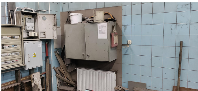
Ośrodek Pracy Twórczej „Wietrznia” – zasilanie główne, licznik energii elektrycznej w skrzynce wewnątrz budynku, tablica bezpiecznikowa i rozdzielcza
